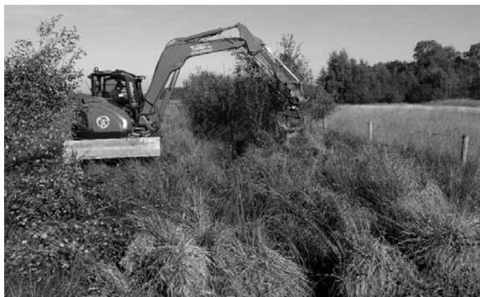
Gehölzentnahme mit Wurzeln mittels Kompaktbagger
